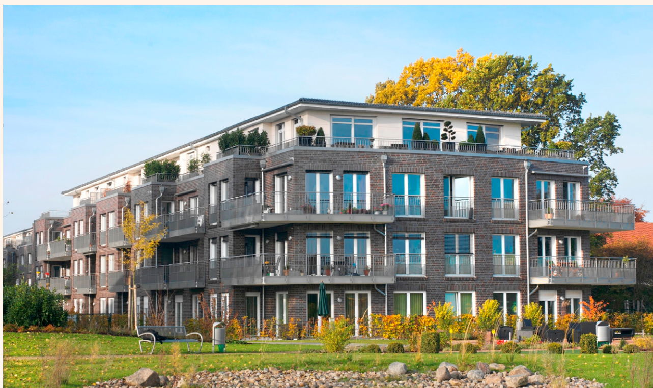
Seniorenresidenz „Wohnpark Weserbogen“ in Bremen, Projektentwicklung JGG, Fertigstellung 2009
